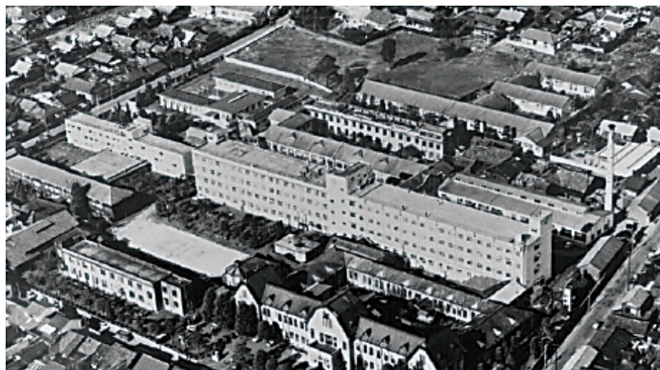
西病棟・東病棟(写真中央)
